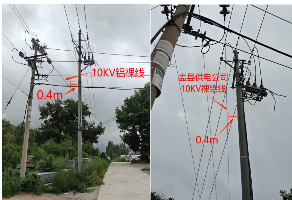
铝裸线距事发电线杆最短距离为0.4m
